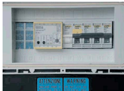
Bild 10. Ersatzstromerzeuger mit Isolationsüberwachungs- und Abschaltvorrichtung [14]
